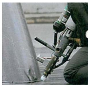
擠壓焊接首先由熱空氣假固定、打毛，再以同樣 HDPE 材質經過擠壓機，擠壓在接縫重疊層上，使其形成封閉式搭接，此種焊接是為精密工程所選用。
